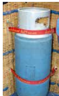
Sichere Befestigung des Gaszylinders
